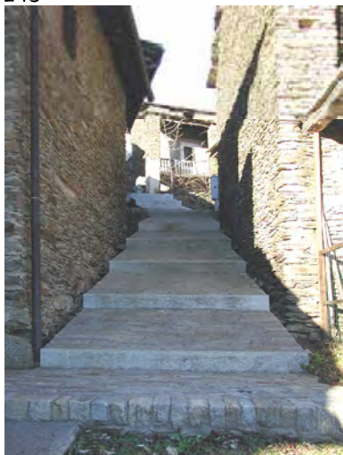
248 percorso esterno sistemato con rampa in pietra: da notare lo stacco dalle murature laterali sistemato a canaletta per il deflusso dell'acqua
