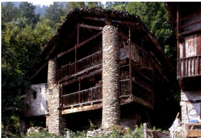
settecentesco lasciò il posto alla simmetria. Sul finire del 1800 - inizio '900 invalse anche l'uso del tondino di ferro nelle ringhiere e della lamiera zincata in sostituzione della paglia e delle scandole del tetto.
