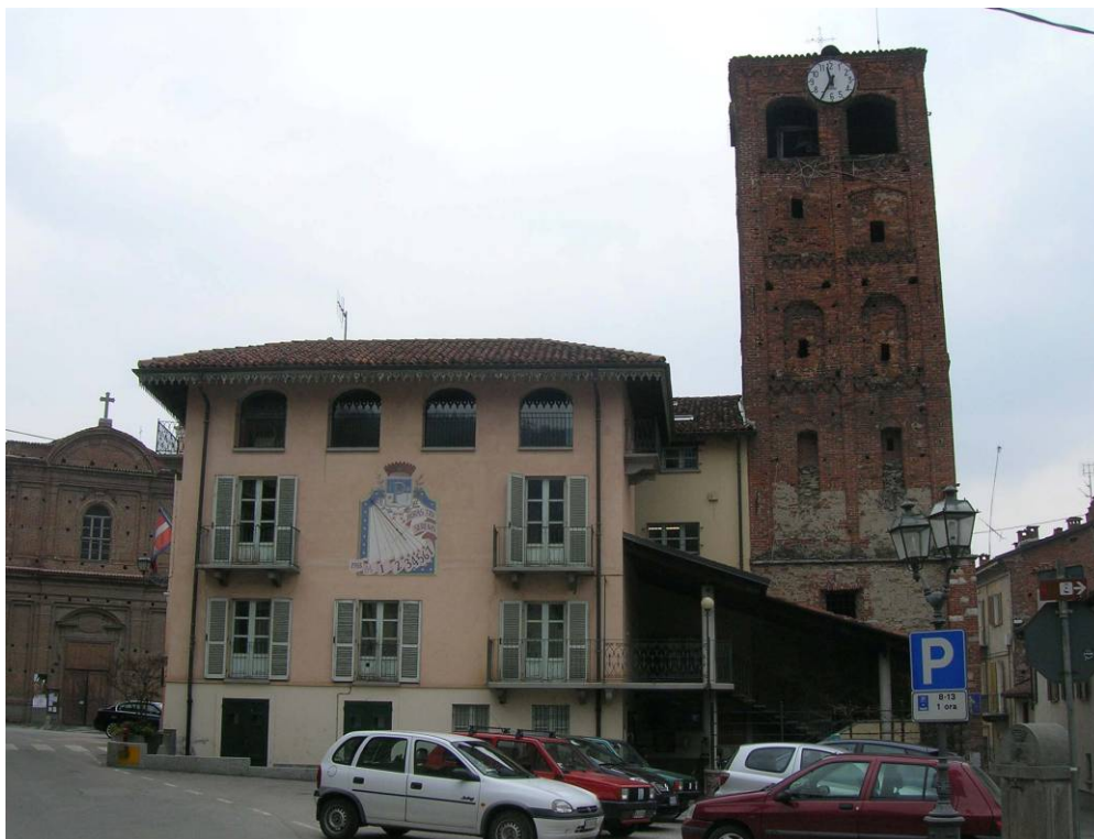
Municipio di Piasco e torre civica
