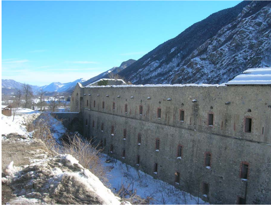
Il Forte Albertino a Vinadio, la manica
