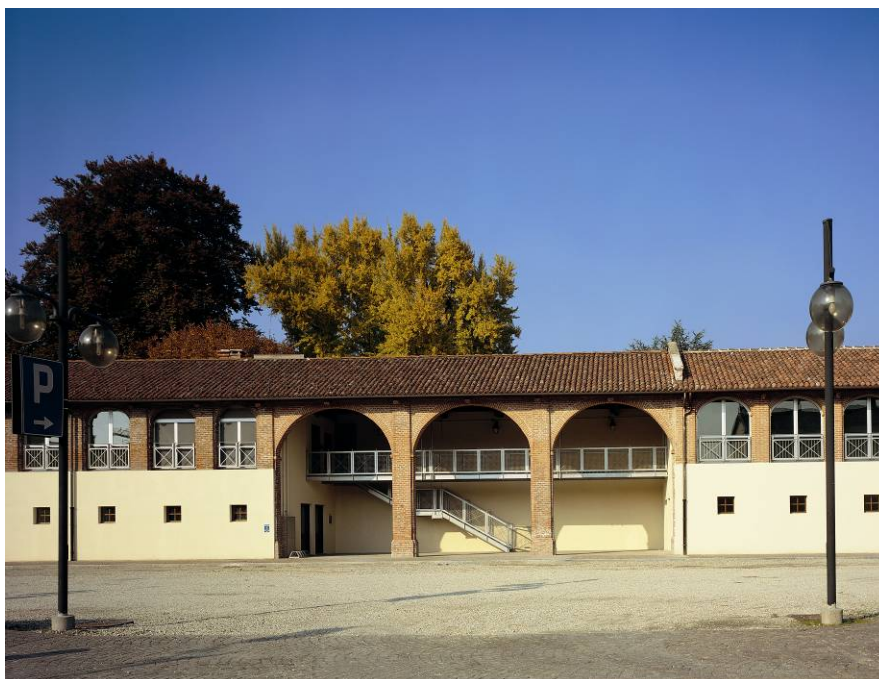
Casalgrasso - recupero della struttura tradizionale ed inserimento di elementi della contemporaneità danno luogo al nuovo organismo edilizio
