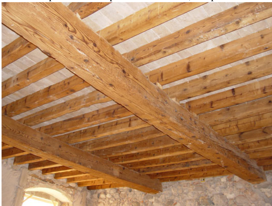
Solaio piano con struttura in legno
